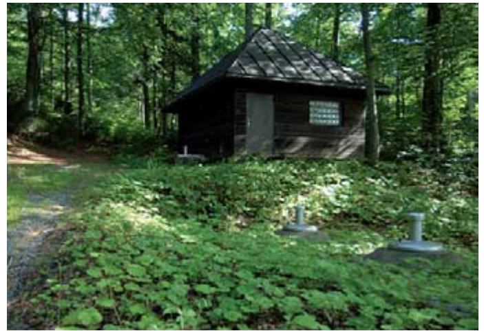
Entsäuerungsanlage der kommunalen Trinkwasserversorgung St. Oswald. Anlage und Betrieb bedurften einer Ausnahmegenehmigung (Foto: Hans Kiener)
